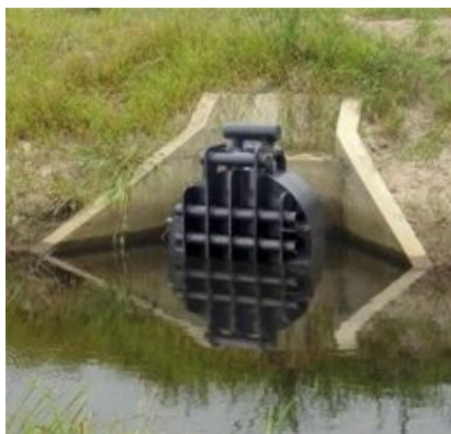
รูปที่ 2-15 ตัวอย่างการติดตั้งประตูระบายน้ำ Flap Valve ที่ปลายท่อระบายน้ำ
