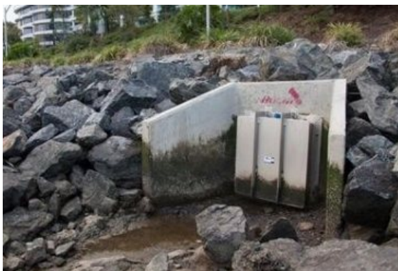
รูปที่ 2-15 ตัวอย่างการติดตั้งประตูระบายน้ำ Flap Valve ที่ปลายท่อระบายน้ำ
